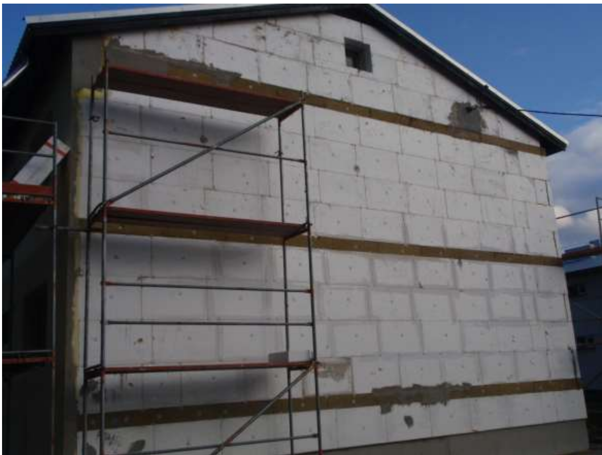
Joonis 3. Paigaldatud projektikohane tuletõkkevill.
