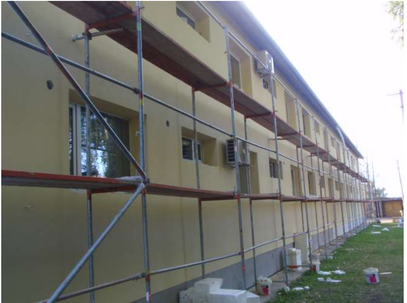
Joonis 5. Viimistluskrohvi paigaldamise lõpetamine.
