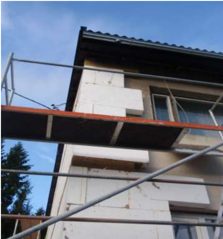
Joonis1. Soojustusplaatide kleepimine.
