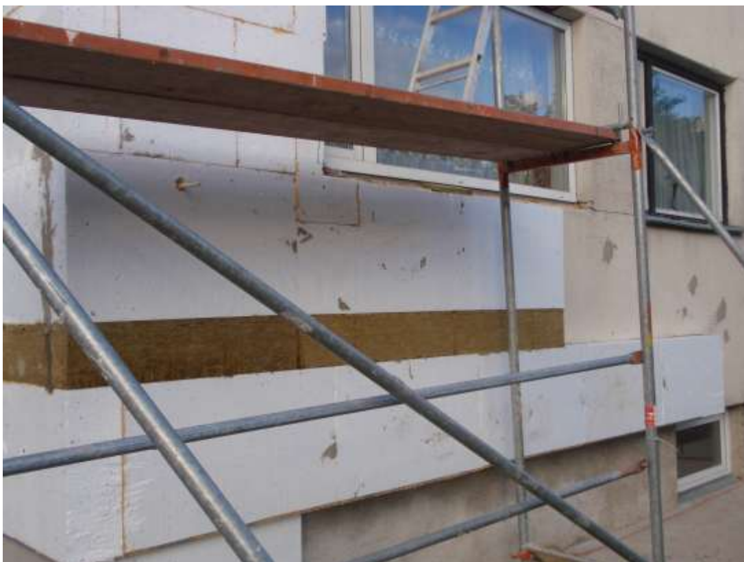
Joonis 3. Paigaldatud projektikohane tuletõkkevill.
